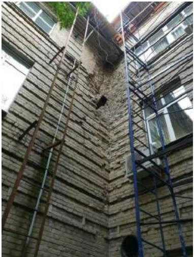
Фото 5. Место разрушения кирпичной кладки в месте сопряжения кирпичных наружных несущих стен здания в осях К-Л/14-15
