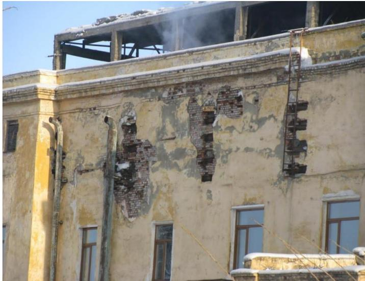
Фото 6. Разрушение штукатурного слоя и кирпичной кладки несущей стены здания турбинного зала
