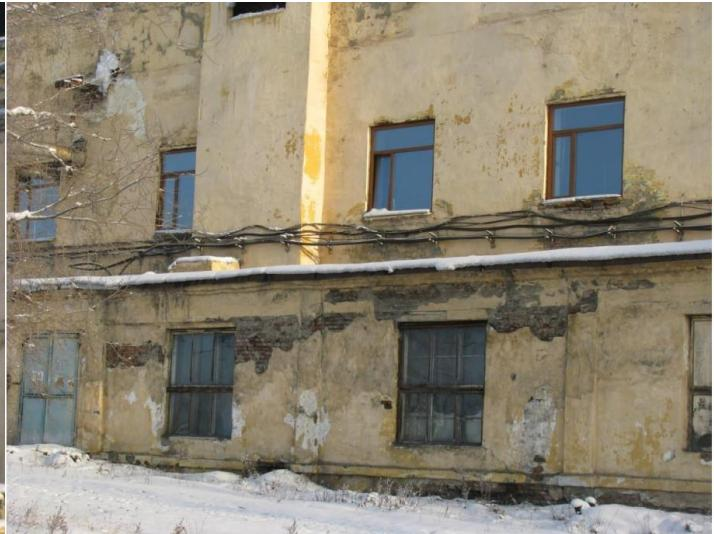
Фото 7. Разрушение штукатурного слоя и кирпичной кладки несущей стены здания турбинного зала
