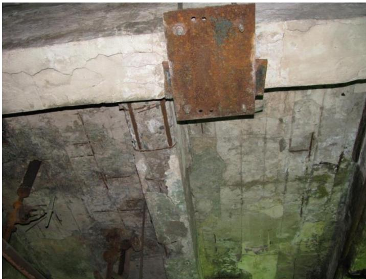
Фото 21. Разрушение защитного слоя бетона железобетонных плит перекрытия и балок, повлекшее оголение и коррозию арматуры
