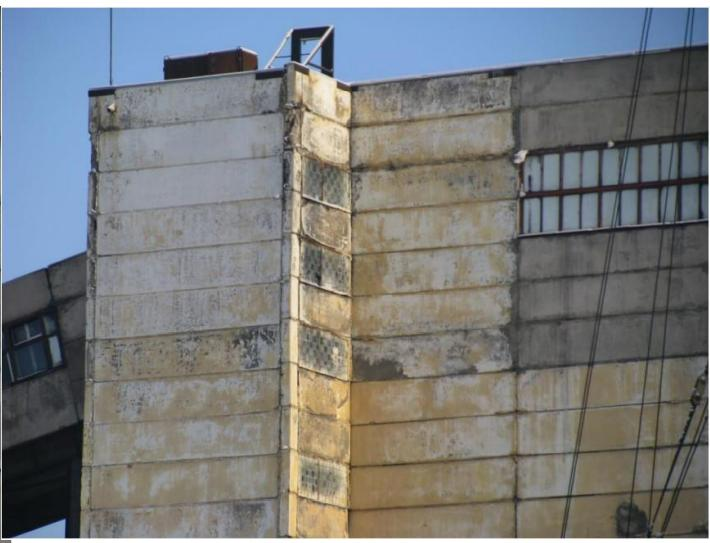
Фото 4. Разрушение железобетонных самонесущих навесных панелей здания котельной
