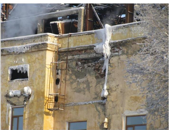
Фото 5. Разрушение железобетонных самонесущих навесных панелей здания котельной
