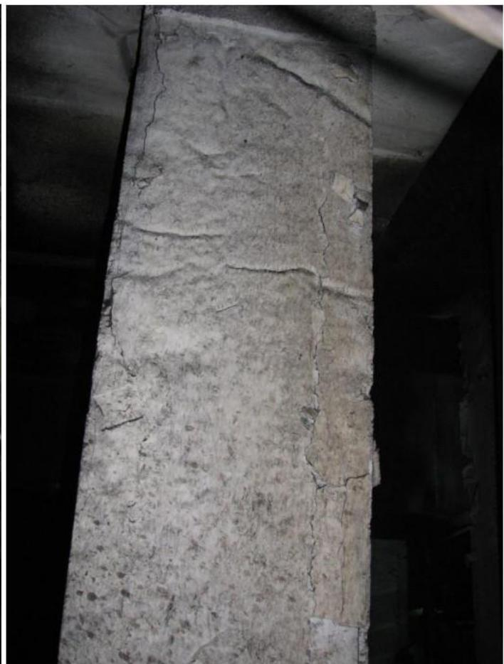
Фото 20. Вертикальная трещина в железобетонной колонне
