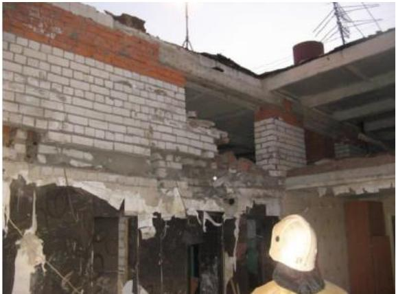
Фото 11. Общий вид поврежденных 4 - 5 этажей в осях А/11-12 кирпичного здания с 5 по 3 этажи
