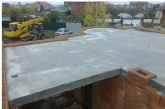
Рисунок 4 - Монолитные железобетонные плиты
