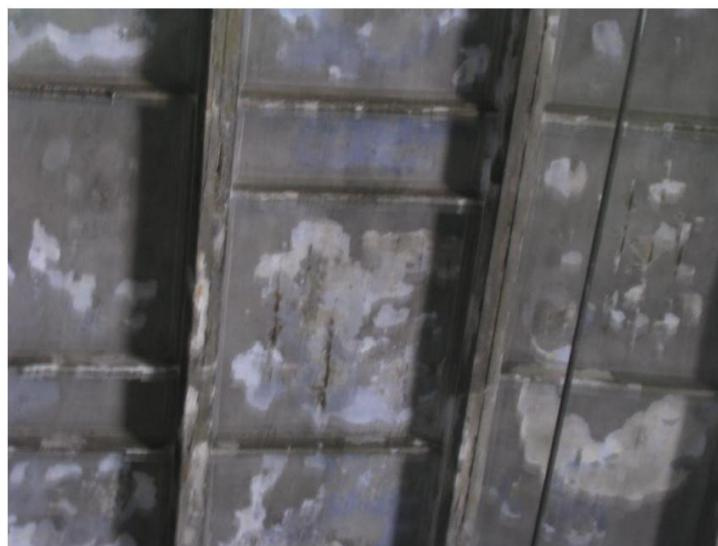
Фото 15. Разрушение защитного слоя, оголение и коррозия арматуры плиты перекрытия турбинного зала
