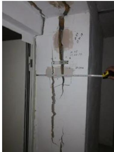
Фото 7. Раскрытие деформационного шва между секциями N 2 и N 3 - 4 и деформации строительных конструкций технического этажа здания в осях И-К/7с-8с (раскрытие шва составляет до 60 мм, но предположительно до 125 мм, см. фото 18)
