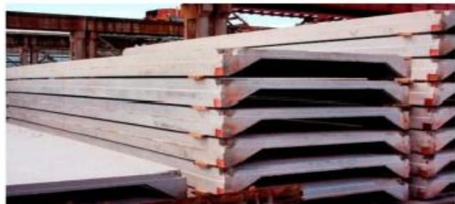
Рисунок 2 - Ребристые железобетонные плиты
