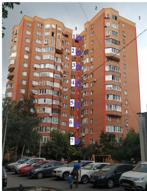
Рис. 2.1. Геодезические измерения снаружи здания
