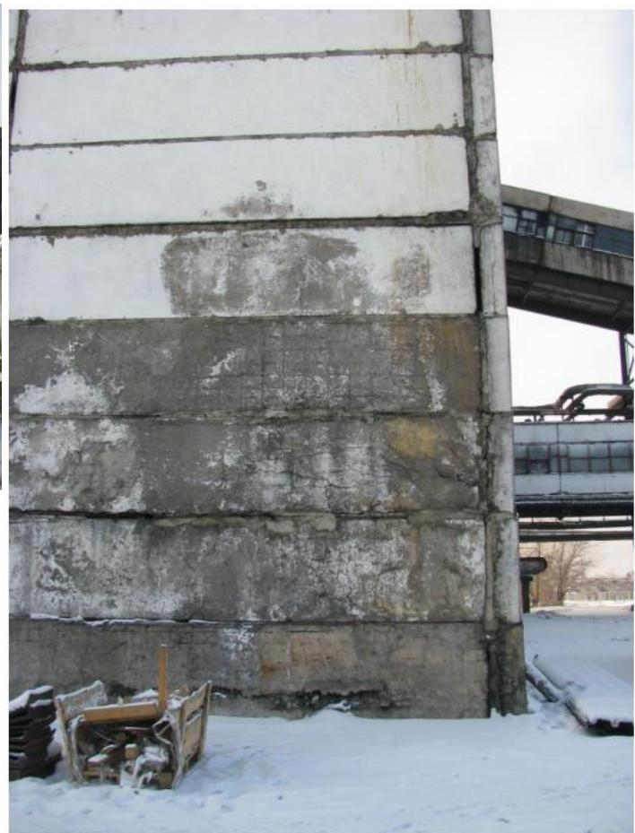
Фото 12. Разрушение железобетонной самонесущей панели здания котельной. Оголение и коррозия арматуры
