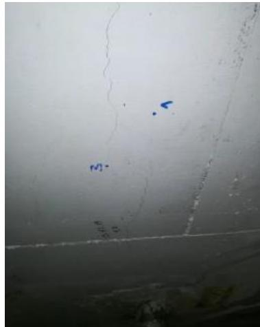
Фото 6. Поперечные трещины длиной до 120 см и шириной раскрытия до 1 мм на плите перекрытия технического подполья здания в осях Гс-Дс/Зс-5с
