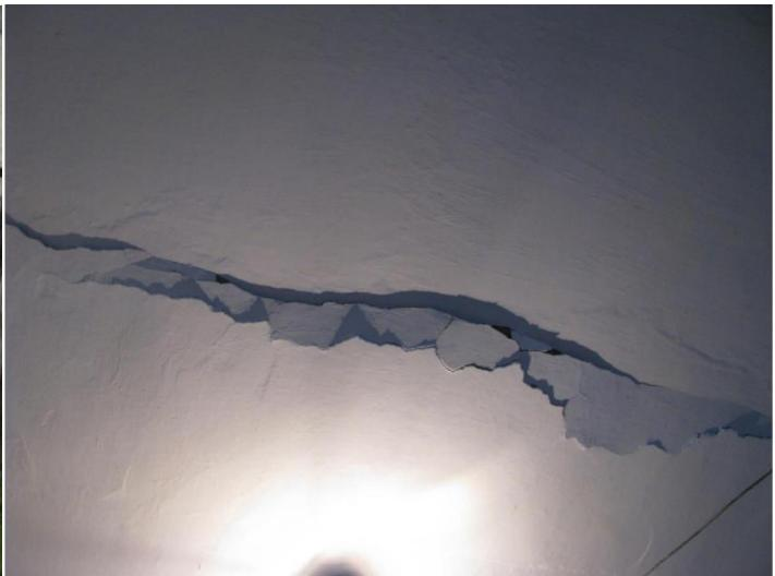
Фото 22. Сквозная трещина в плите перекрытия
